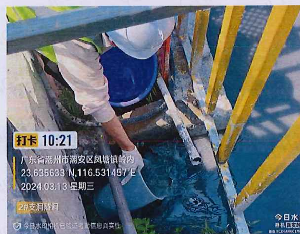
施工 1 标 2#支洞隧道洞口排水
