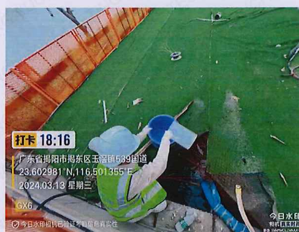
施工 2 标 GX6 生产废水
