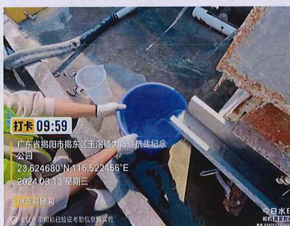
施工 1 标 3#支洞隧道洞口排水
