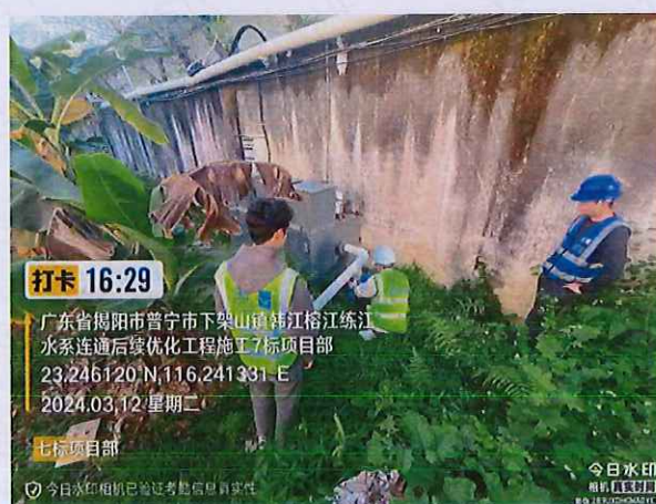
施工七标项目部厨房生活污水
