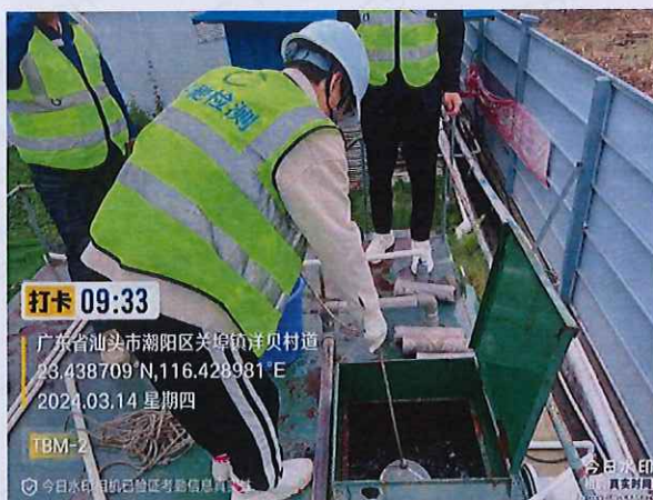
施工 5 标 TBM 隧道开端生活污水
