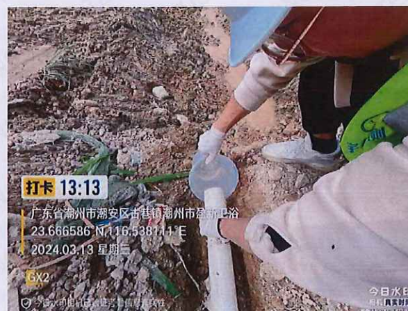
施工 3 标 GX2 厨房生活污水
