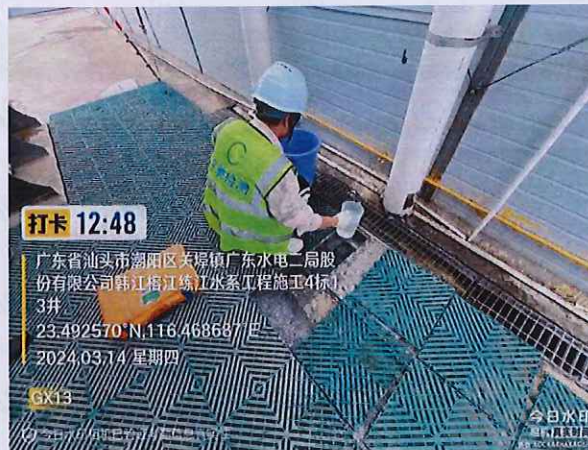
施工 4 标 GX13 厨房生活污水
