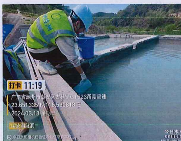
施工 1 标 1#支洞隧道洞口排水
