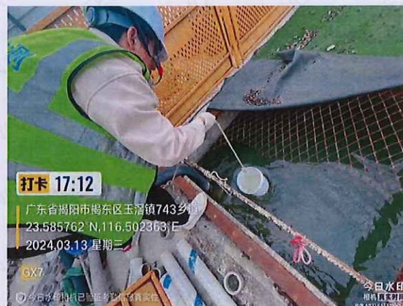
施工 2 标 GX7 生产废水
