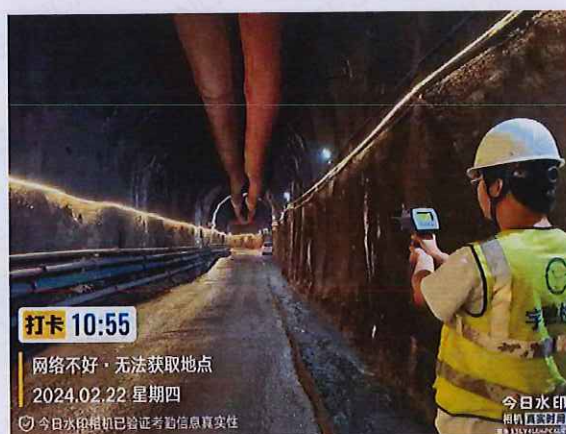
主干线隧洞段 3#支洞 350 米处
