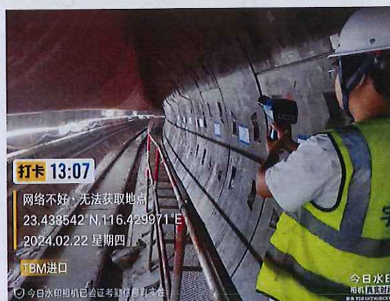
TBM 隧道洞口开端 300 米处
