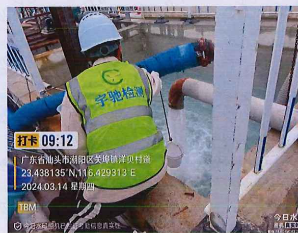
施工 5 标 TBM 隧道开端洞口排水
