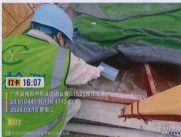
施工 2 标 GX12 生产废水
