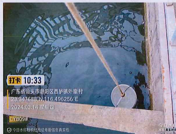
施工 5 标 CYB09#生产废水
