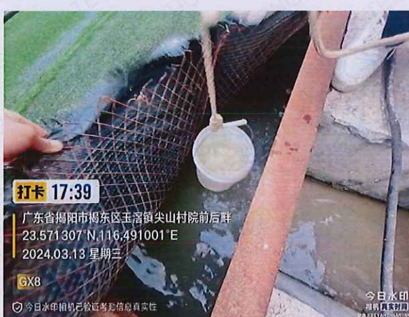
施工 2 标 GX8 生产废水
