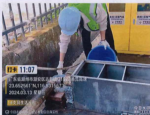
施工 1 标 1#支洞厨房生活污水
