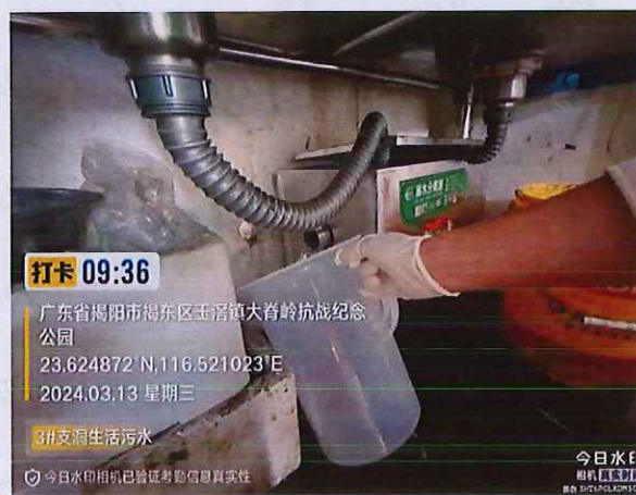
施工 1 标 3#支洞厨房生活污水
