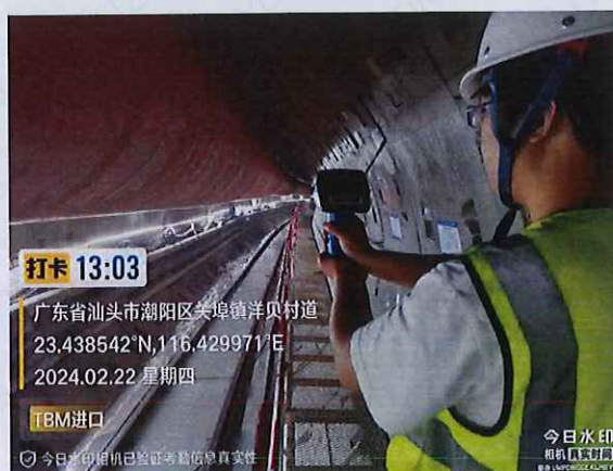
TBM 隧道洞口开端 250 米处
